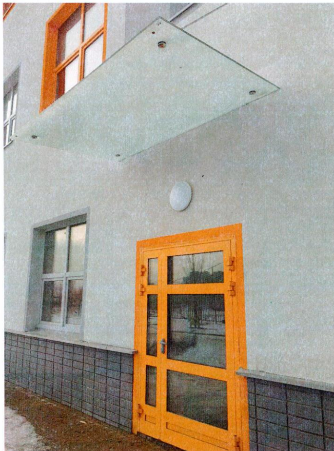
Козырек перед испытанием
